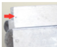
Ausencia de calzo
