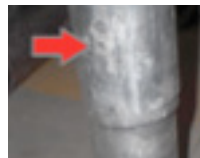
Golpes y ausencia de tornillos de sujeción
