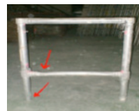
Golpes y deformaciones
