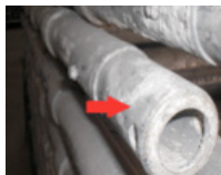
Golpes y ausencia de tornillos de sujeción
